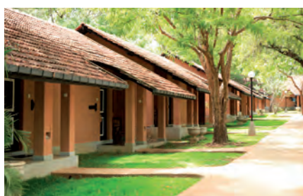
Habarana Village, Habarana
